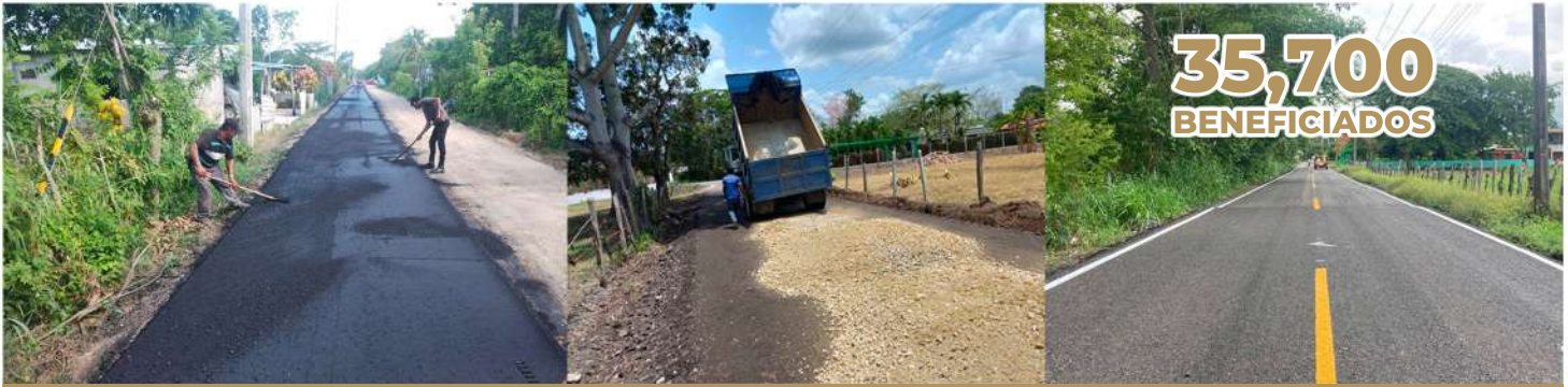
Mejoramiento a las vías carreteras. 2,161.49 m a base de mezcla asfáltica y 931.26 m 2 con concreto hidráulico.
